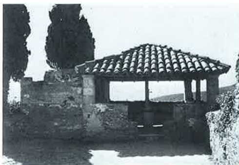
Façana nord del comunidor (23 novembre 1981 i 15 abril 1983).
