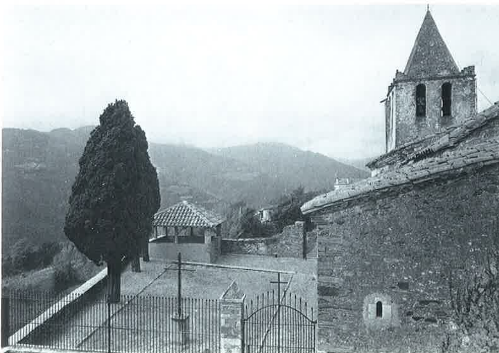
Vista del conjunt després de la intervenció (21 abril 1983).
