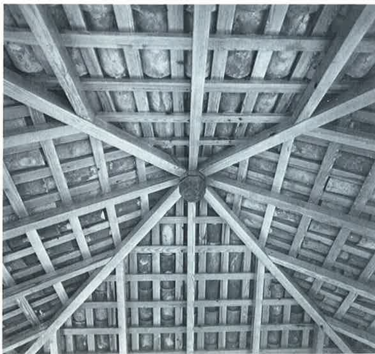
Estructura de la coberta (març 1980 i març 1983).
