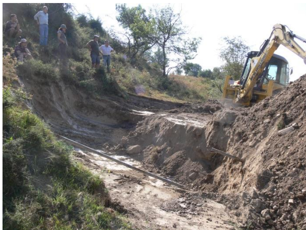
1. Inici de l'excavació en extensió a l'est de la canonada.
