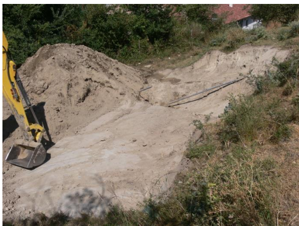
3. Moment en què s'aturà l'excavació mecànica en aparèixer indicis que feien sospitar algun canvi (una petita acumulació de còdols).
