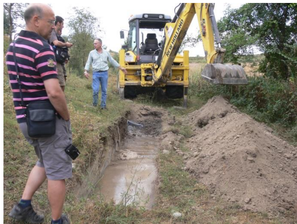
4. Moments de confusió quan, pocs minuts després de l'inici dels treballs, la màquina perforà una canonada d'aigua potable.
