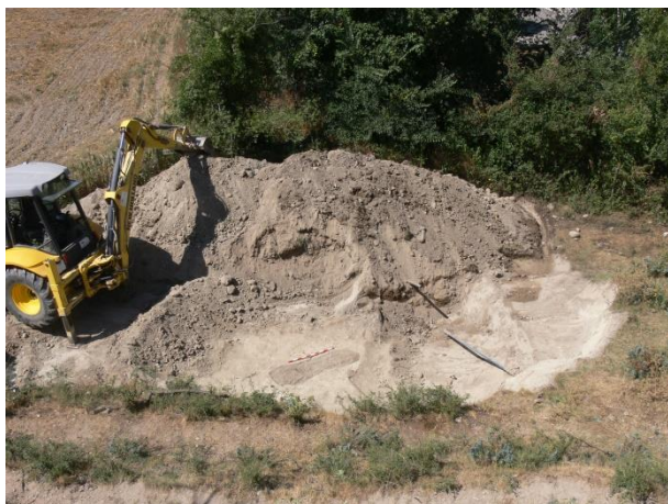
5. Ubicació de la fossa des d'una posició elevada.
