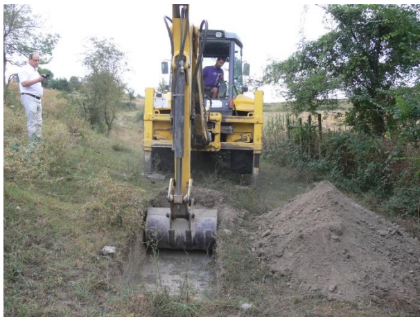
3. Inici de l'excavació de la rasa de prospecció amb culler a de neteja arran de camí per alliberar la zona per poder ubicar-hi la terrera.
