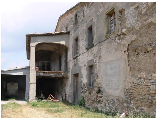
1. Façana sud del Mas del Puig – Puigdesalit.
