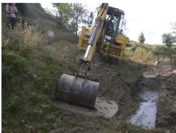
5. Inici de l'excavació en extensió a l'oest de la canonada, un cop finalitzada la rasa de prospecció arran de camí.
