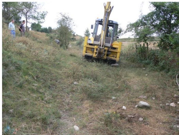
2. Zona de treball un cop la retroexcavadora se situava a la zona del camí.
