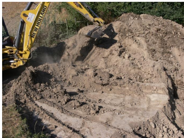
2. Excavació en extensió a l'est de la canonada.
